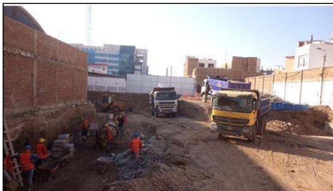
Vista de los trabajos de movimiento de tierras en la ubicación de la futura edificación.
