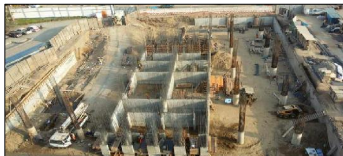
Vista del reinicio de obras a nivel de sótano.
