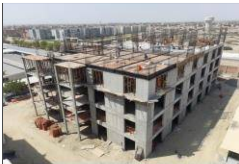
Vista del estado actual de la edificación de 10 niveles.
